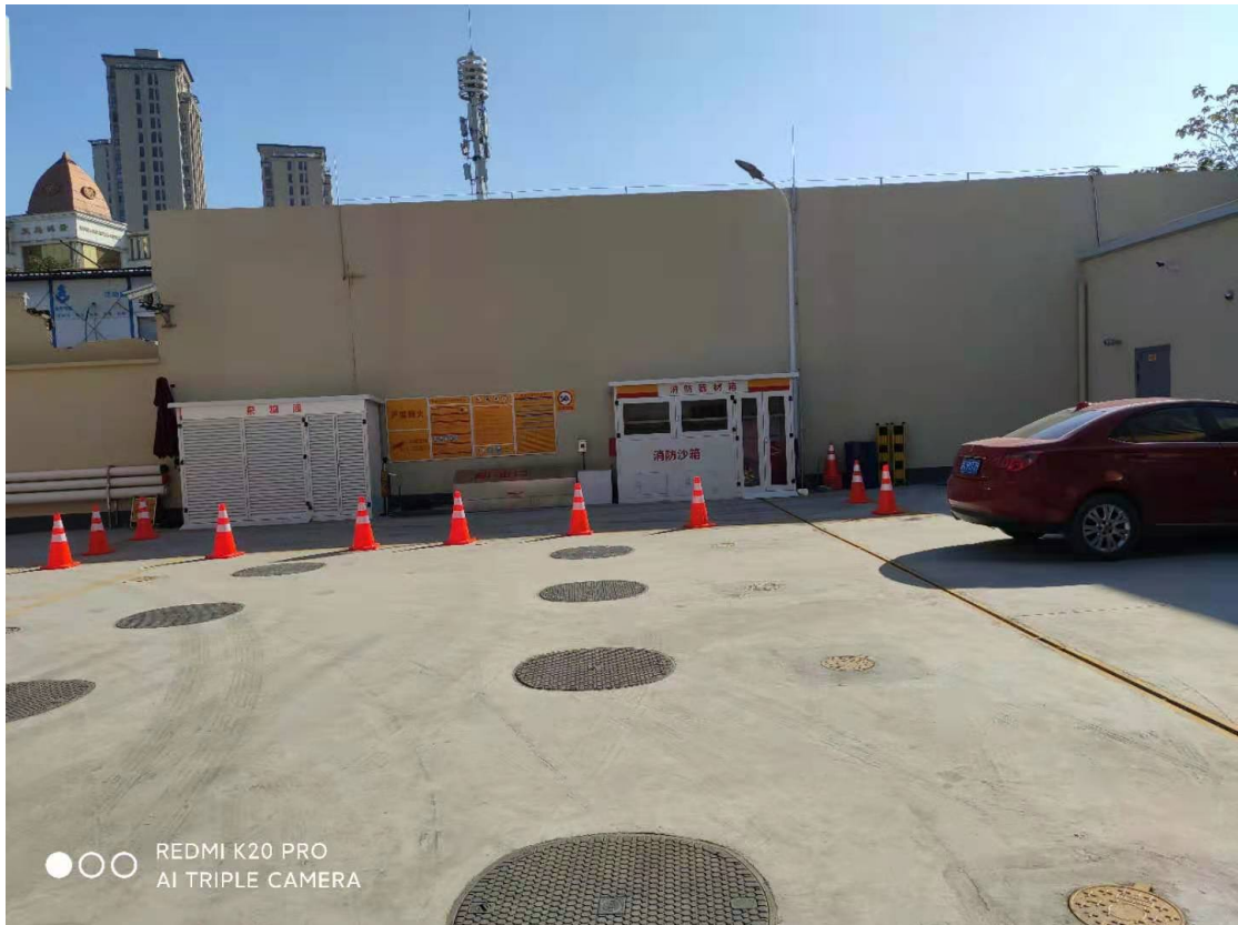
附图3 危废暂存间
